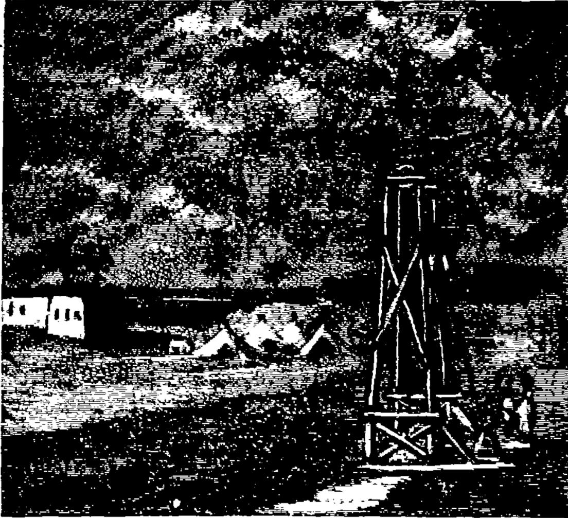
Appareil de sondage pour le percement des puits artésiens.
