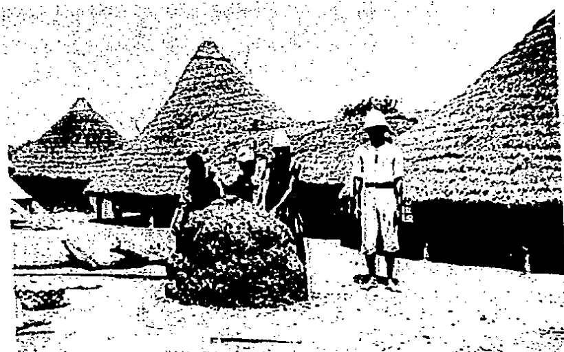
Construction d'une borne astronomique.
